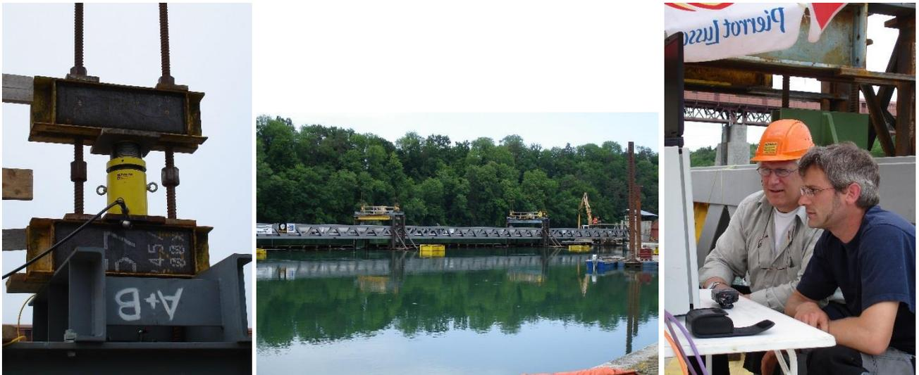
⇒ Synchrone Bewegung mit max. 16 Hydraulikzylindern
