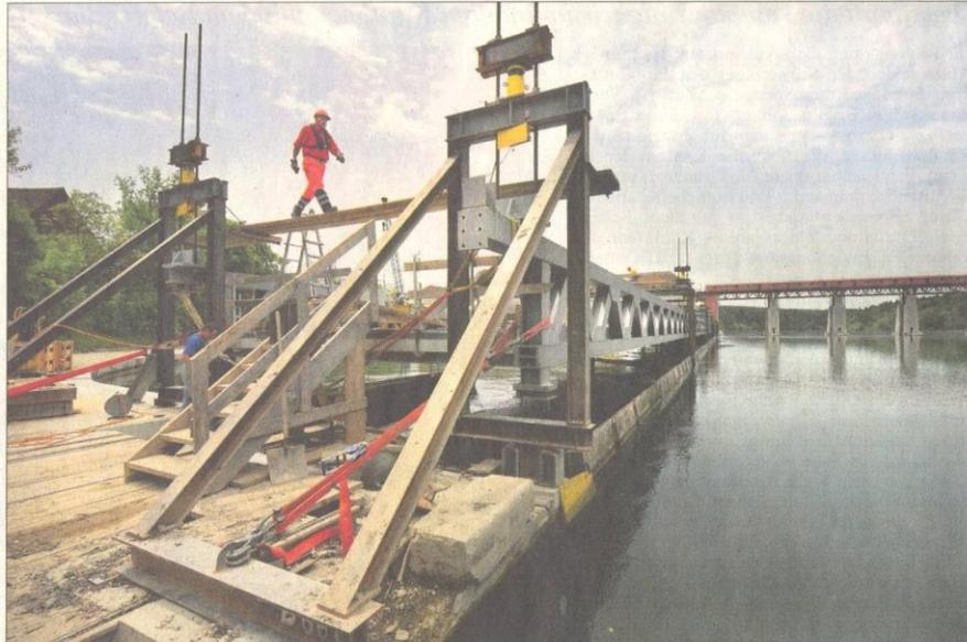
Die neue Rechenbrücke beim Kraftwerk Eglisau hängt an sieben stählernen Jochen. Mit hydraulischen Pressen (gelbe Zylinder) wird sie in ihre endgültige Position knapp über der Wasseroberfläche abgesenkt. ADRIAN BAER
